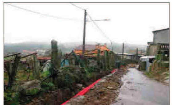
Las obras en la Rúa Igrexa de Chandebrito.
